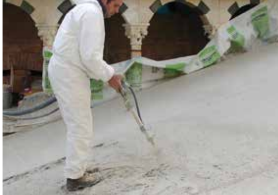
MasterEmaco® S 285 TIX kullanılarak tuğla çatının mantolanması
