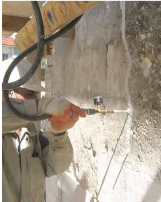
MasterInject® 222 ile çatlak onarımı
