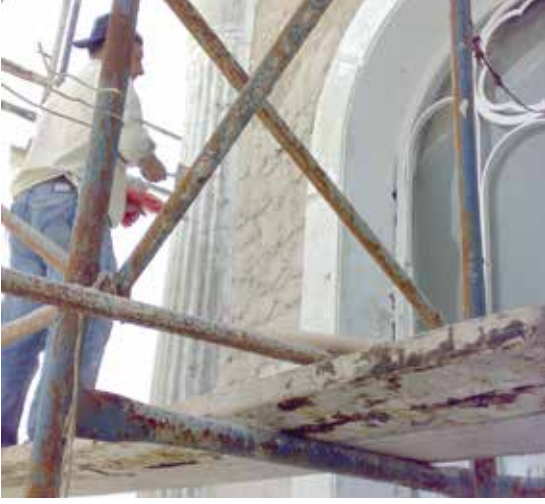
MasterEmaco® N 275 TIX'in mala ile uygulanması
