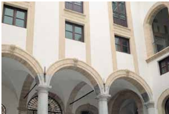
MastereEmaco® sıvalar kullanılarak tamamen yenilenmiş bir bina cephesinin genel görünüşü
