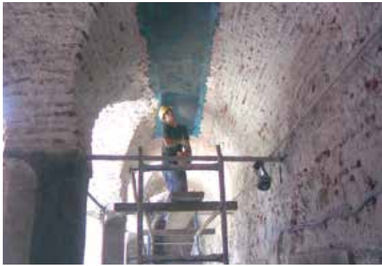
MasterBrace® FIB kullanılarak tuğla tonoz güçlendirilmesi
