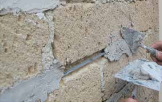
Karbon lifli fiber çubuk (MAsterBrace® Bar) ve MasterEmaco® S 285 TIX ile duvar derzinde yapılan güçlendirme uygulaması
