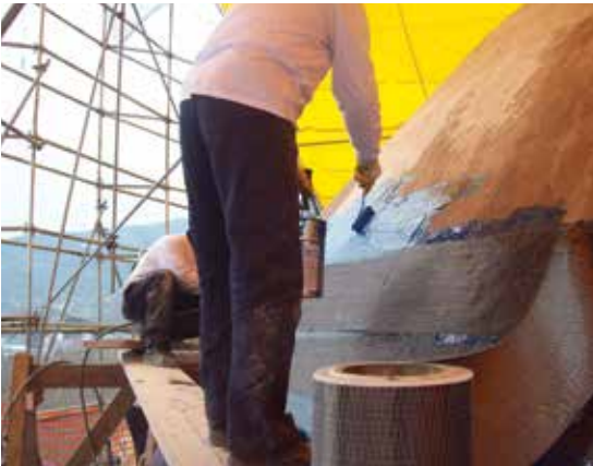
MasterBrace® FIB kullanılarak kubbe güçlendirilmesi
