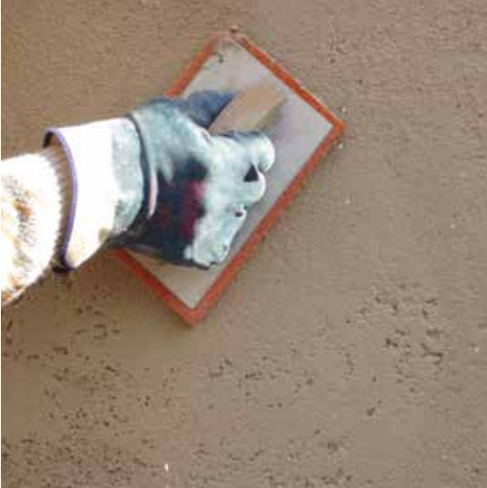
MasterEmaco® N 275 TIX'in perdahlanması
