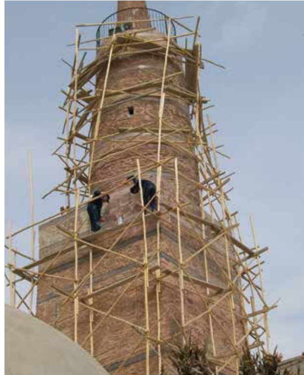
Tuğla minarenin lifli polimer kumaşlar ile güçlendirilmesi
