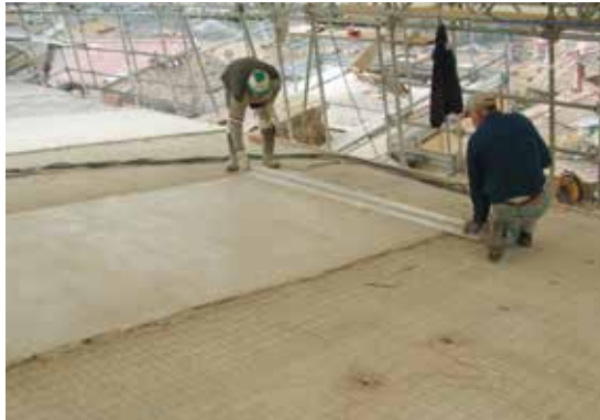
MasterEmaco® S 285 TIX'in perdahlanması
