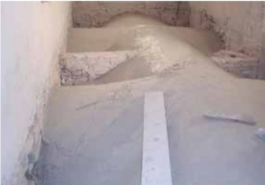
MasterEmaco® S 285 TIX ile mantolamanın bitirilmesi
