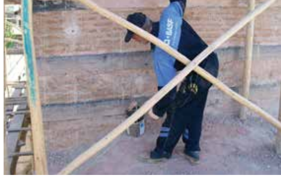
MasterBrace® FIB kullanılarak tuğla minare güçlendirilmesi
