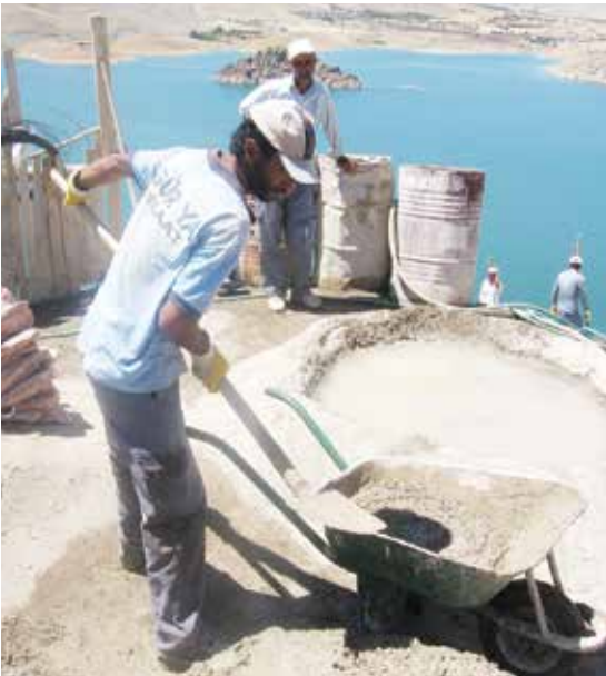
MasterEmaco® A 265 kullanılarak yapılan özgün harç hazırlığı
