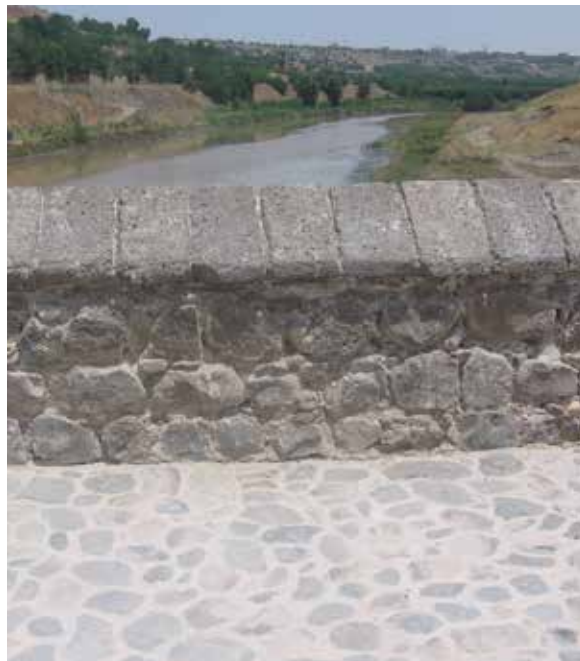
MasterEmaco® S 285 TIX ile onarılmış tarihi köprü döşeme derzleri
